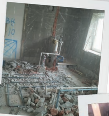
... und die Baustelle bei ihrem Haus in Niedernhaag wurde auch abgeschlossen
